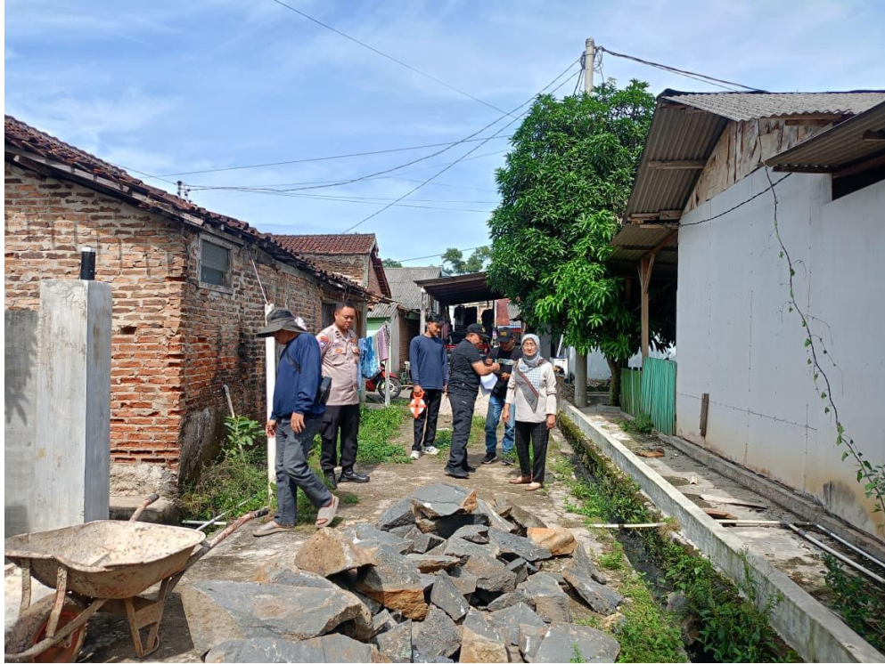
Perbaikan Jalan di Wilayah Kelurahan Tejo Agung 03 Oktober 2025
